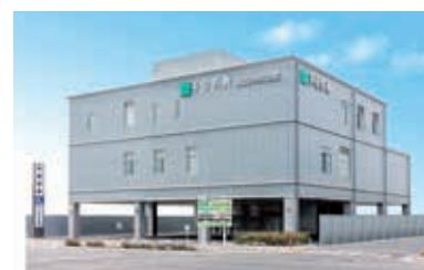
平安祭典 岡山中央会館 岡山市北区大元上町2-3
